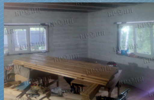
Хабаровск, тепло и гидроизоляция деревянного дома материалами Броня
