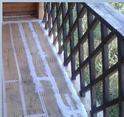
Гидроизоляция деревянного пола на веранде в г. Алматы, Республика Казахстан
