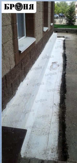
Алматы, Гидроизоляция на швах примыкания паркинга к стене дома
