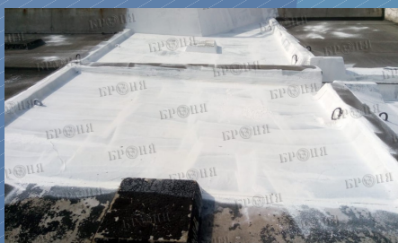
Химки, Гидроизоляция кровли 2х жилых домов
