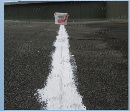
Гидроизоляция плоской кровли жилого дома в г. Санкт-Петербург.
