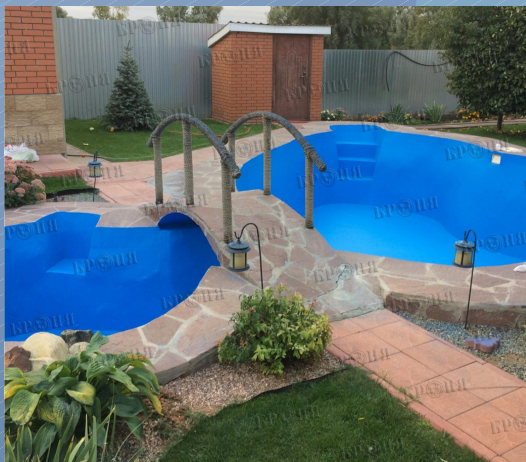
Самарская область, гидроизоляция Бассейна Полимерным Гидроизолятором Броня АкваБлок
