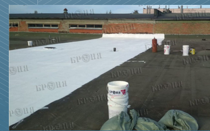
Пермь, пермский водоканал гидроизоляция кровли
