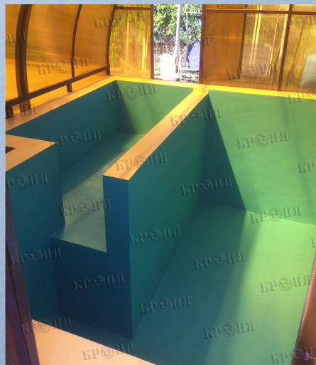
Самарская область, Гидроизоляция бассейна
