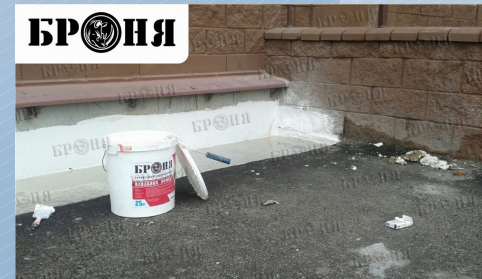
Алматы, Гидроизоляция на швах примыкания паркинга к стене дома
