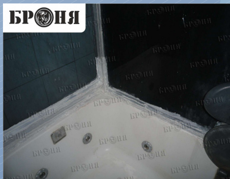
Волгоград Гидроизоляция ванной комнаты
