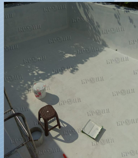
Георгиевск, гидроизоляция бассейна частного домовладения Броня АкваБлок
