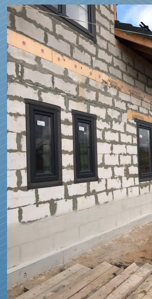
Броня Лайт и Броня Акваблок, тепло и гидроизоляция цоколя частного дома. Химки
