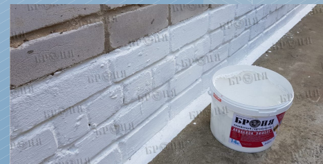
Волгоград, Полимерный гидроизолят ор Броня АкваБлок на цоколе жилого дома
