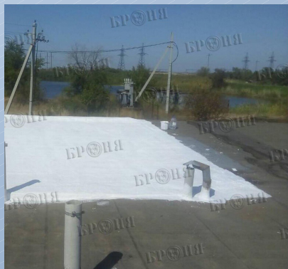
Волгоградская область, гидроизоляция крыши гаража
