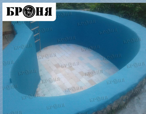
Лопатино Пензенско й области, гидроизоляция бассейна
