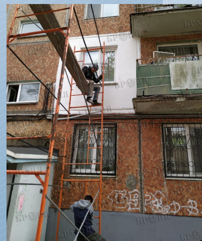
Владивосток, утепление стены квартиры с внешней стороны
