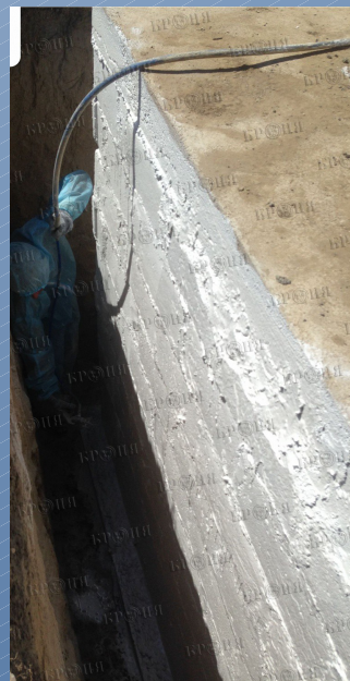
Георгиевск, гидроизоляция подвала частного дома
