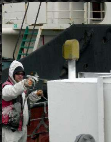
Изоляция рубки и технологических емкостей для хранения нефтепродуктов на речной барже
